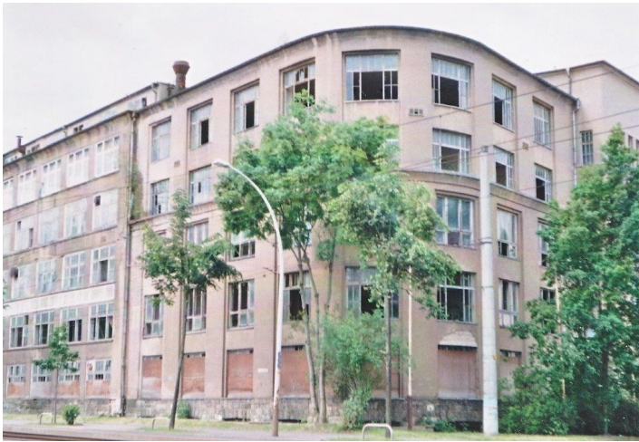
Werk II, Waplerstraße 1 (Aufnahme 2014 – war bis 1990 Sitz des VEB Nadel- und Platinenfabrik). Foto: Dietmar Wendler
